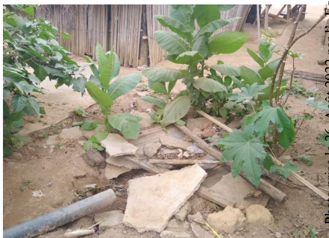
Fausse septique construite par M .SAMA YAMBA pour l'évacuation de l'eaux de douche
